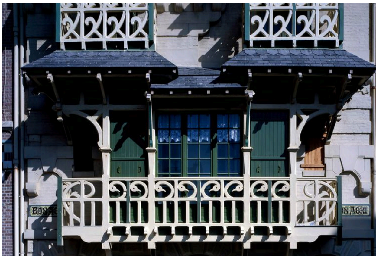
Détail des balcons.
