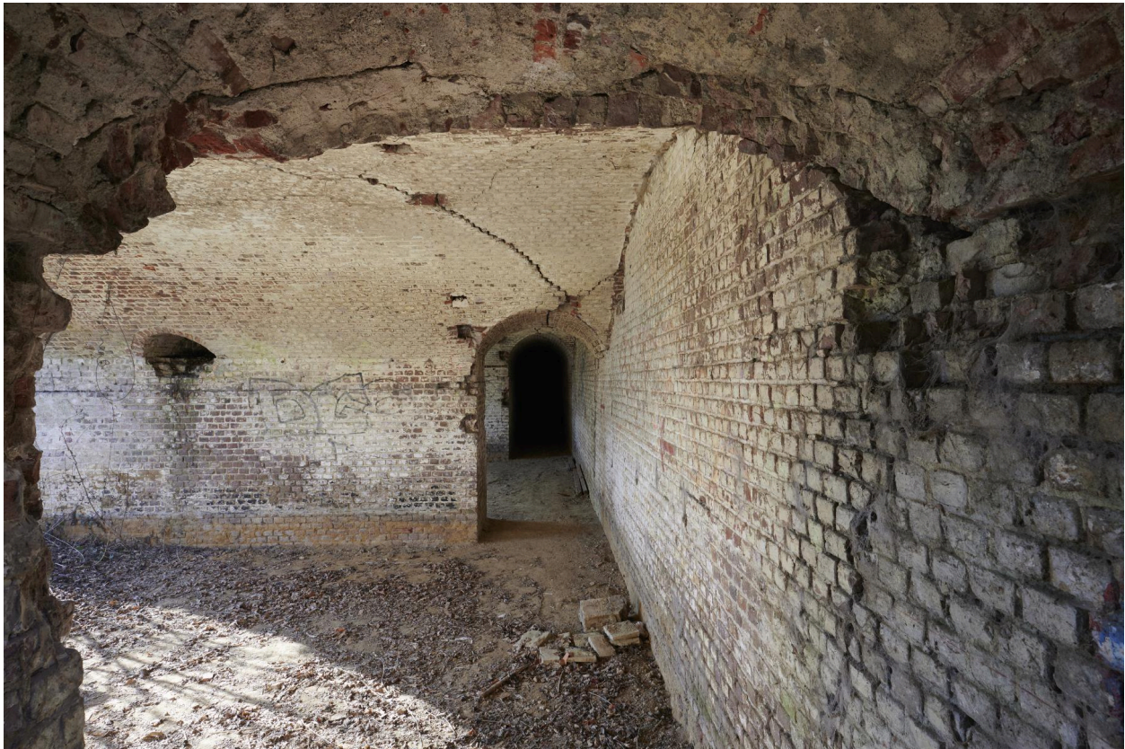
Couloir reliant les chambres des sous-officiers (aile ouest).
