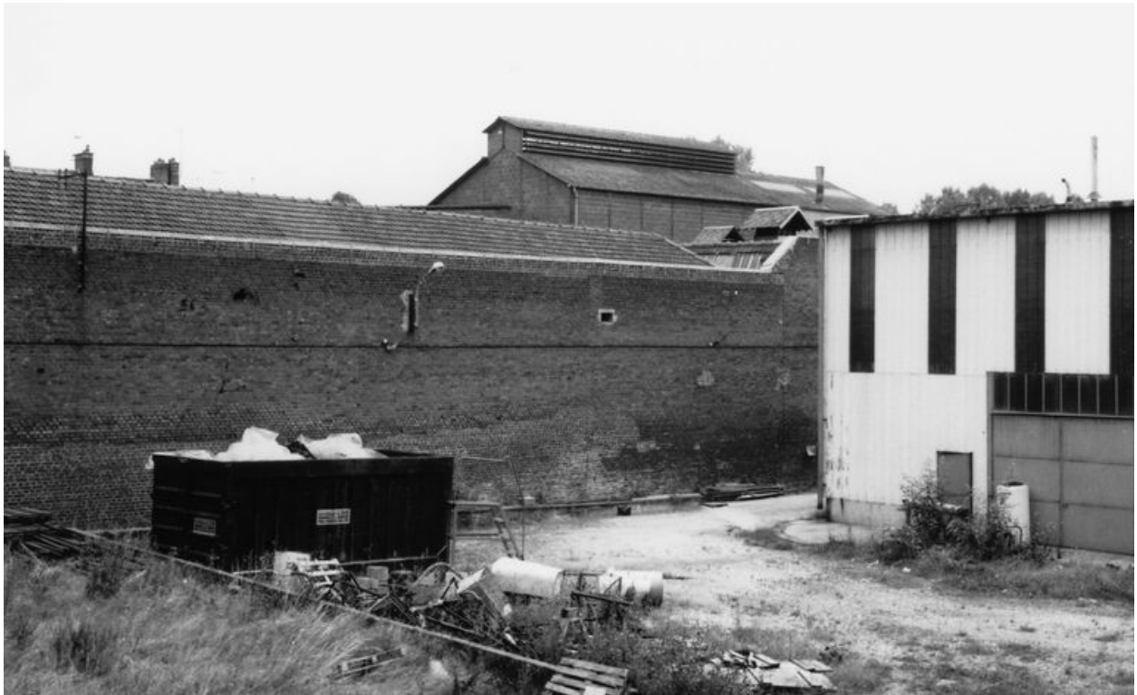
Vue du mur de clôture depuis l'ouest, les salles des machines à l'arrière-plan.
