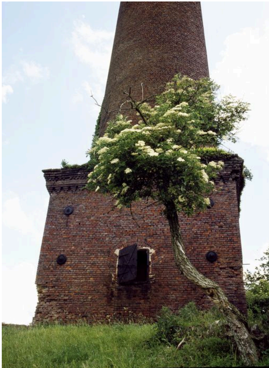
Socle d'une cheminée d'usine.
