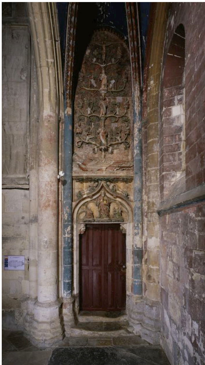
Vue générale, avant restauration.
