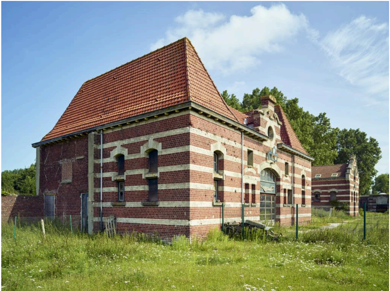
Laiterie et magasin, vue de trois-quarts sud-ouest.
