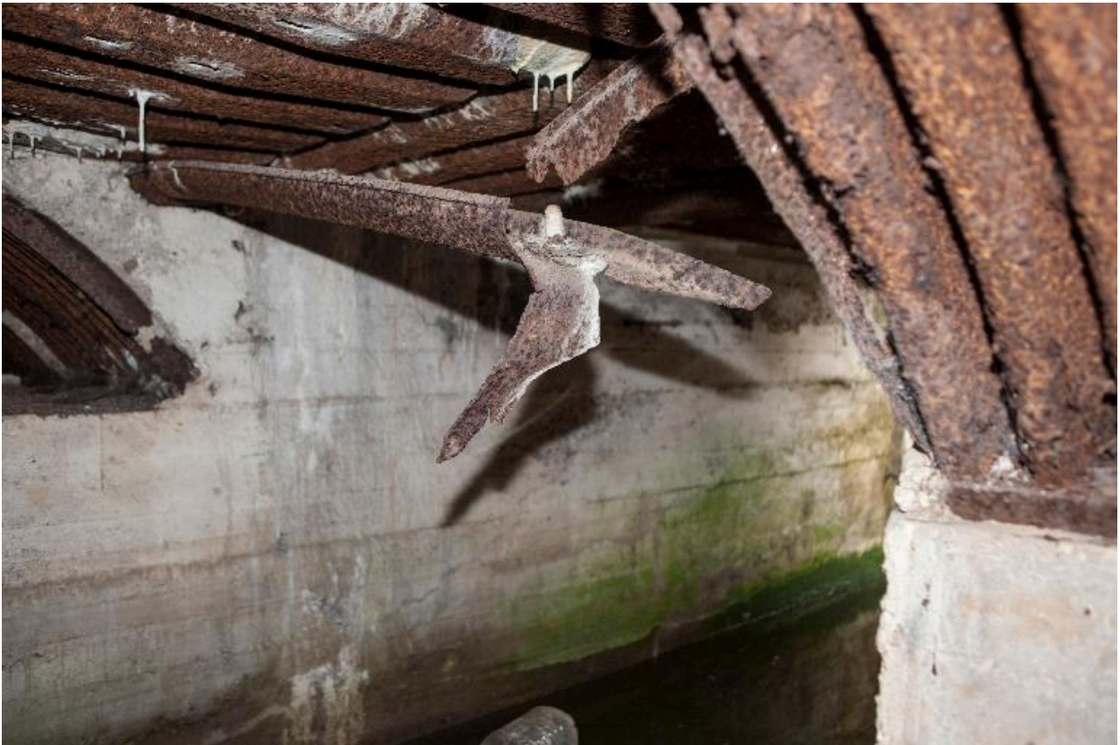
Détail d'une tôle de coffrage
