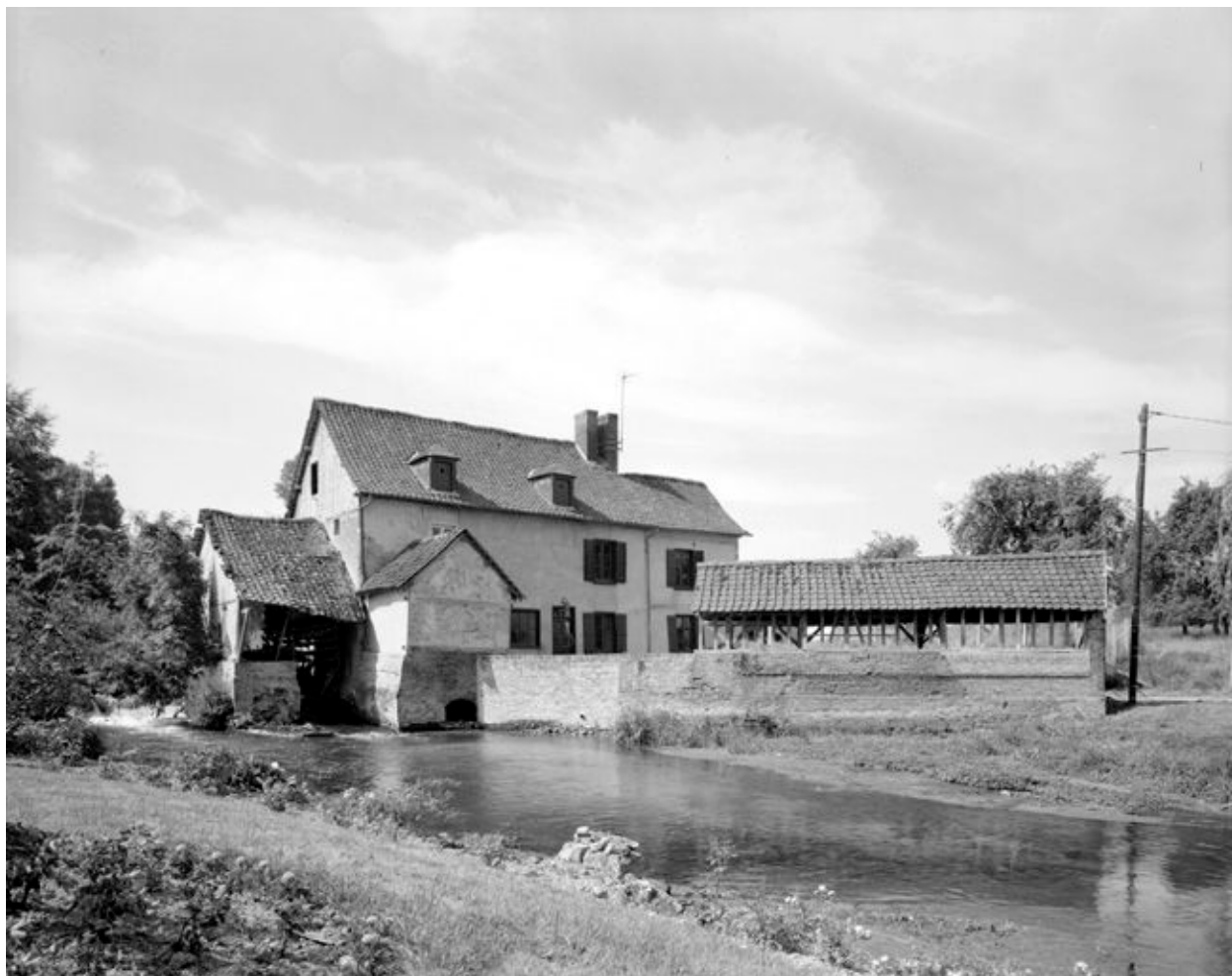
Vue générale, flanc nord-est.
