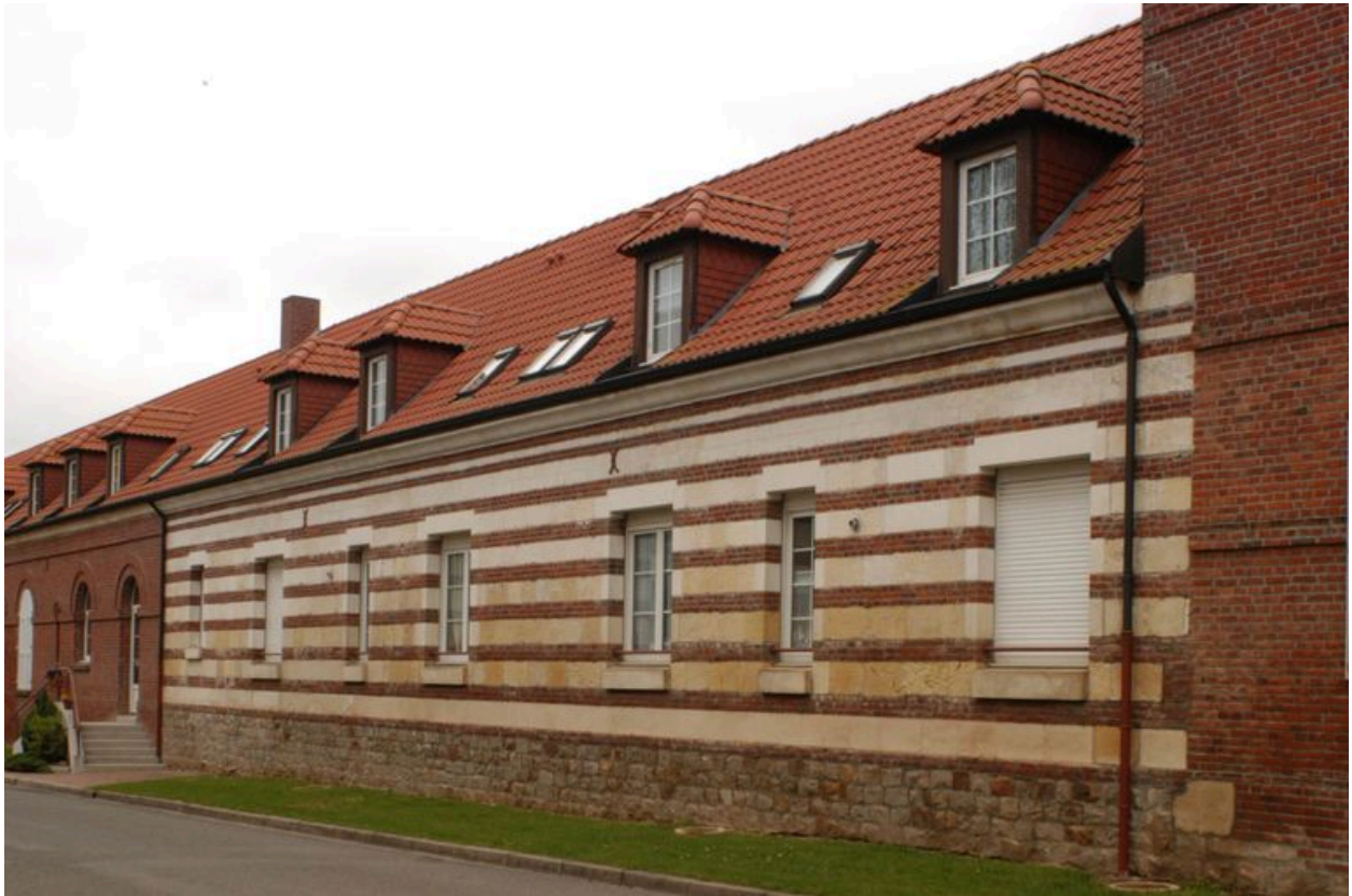
Anciennes dépendances du château : corps central côté rue.
