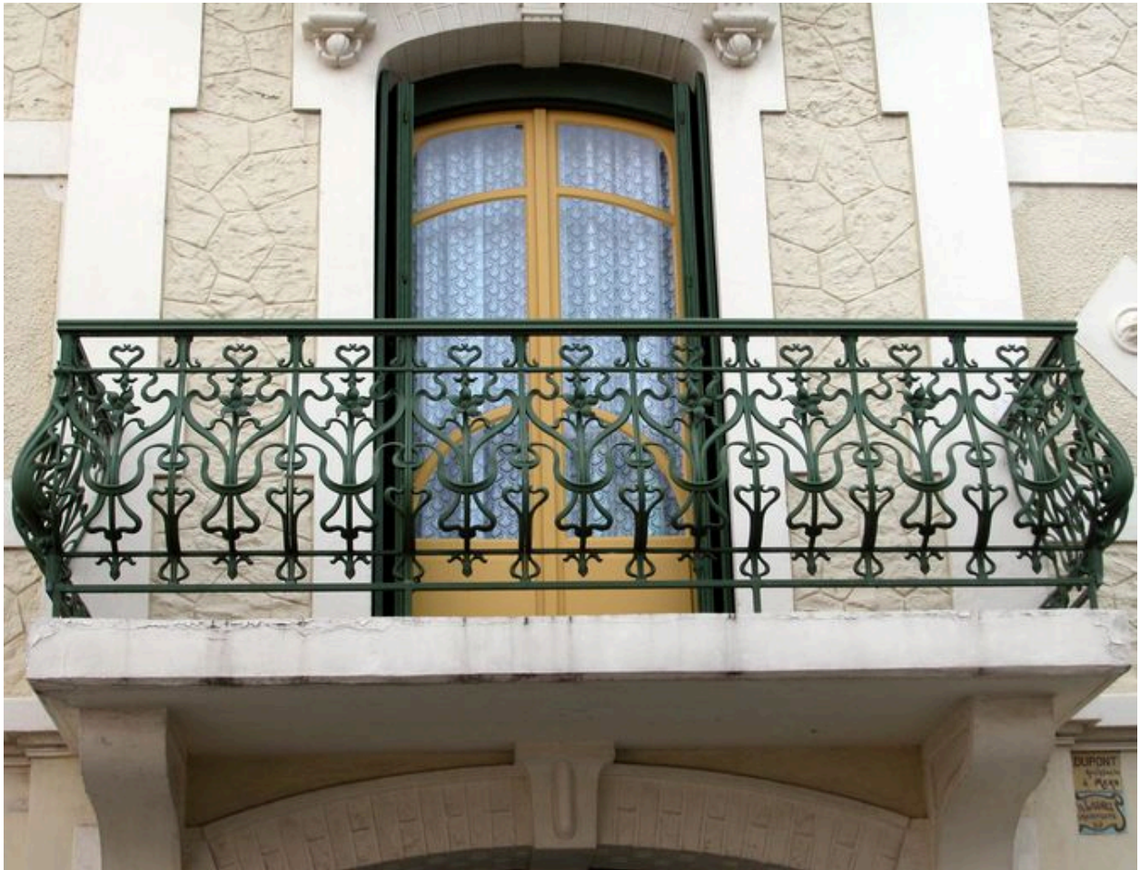
Détail du garde-corps de balcon en fonderie.
