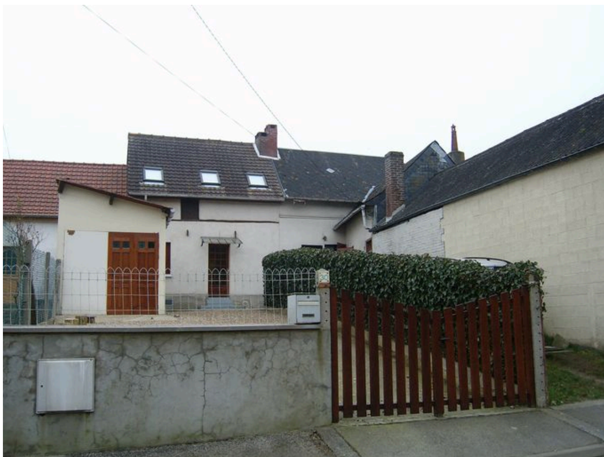
Ancienne ferme, 28 rue du Canal (1982 A3 359).
