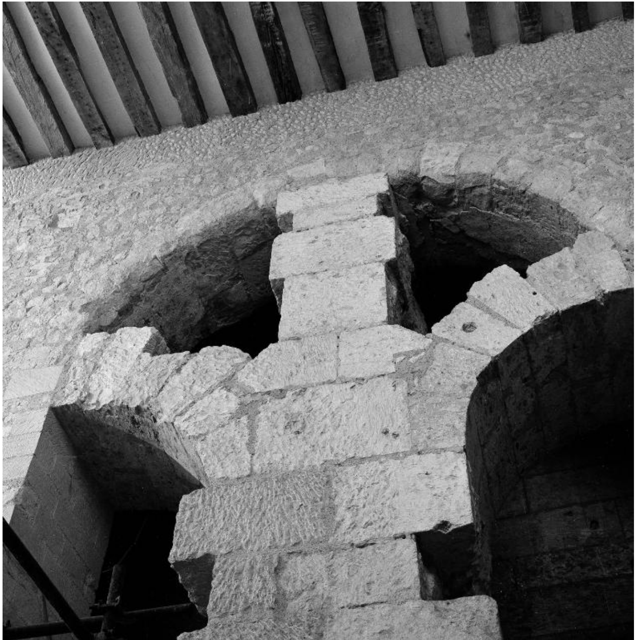
Arcade du collatéral sud de la nef, encore en élévation (10e-11e siècles).
