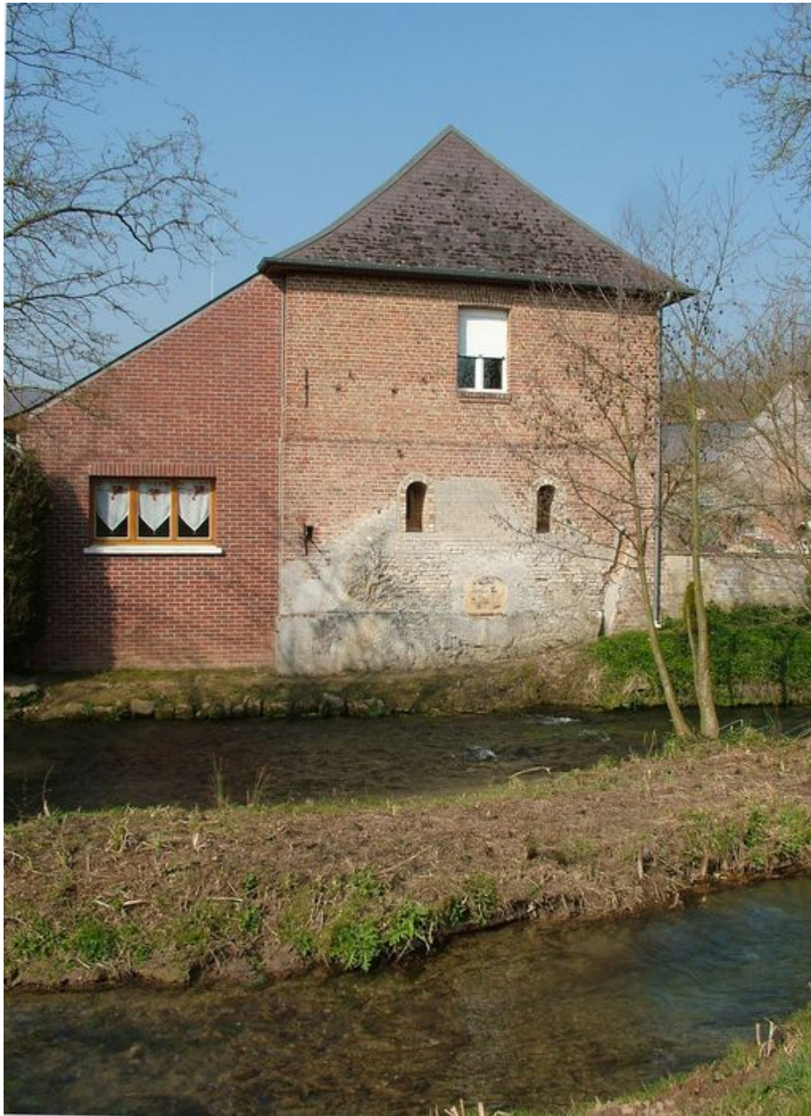
Mur de croupe de l'ancien moulin portant la trace de l'ancienne roue hydraulique.
