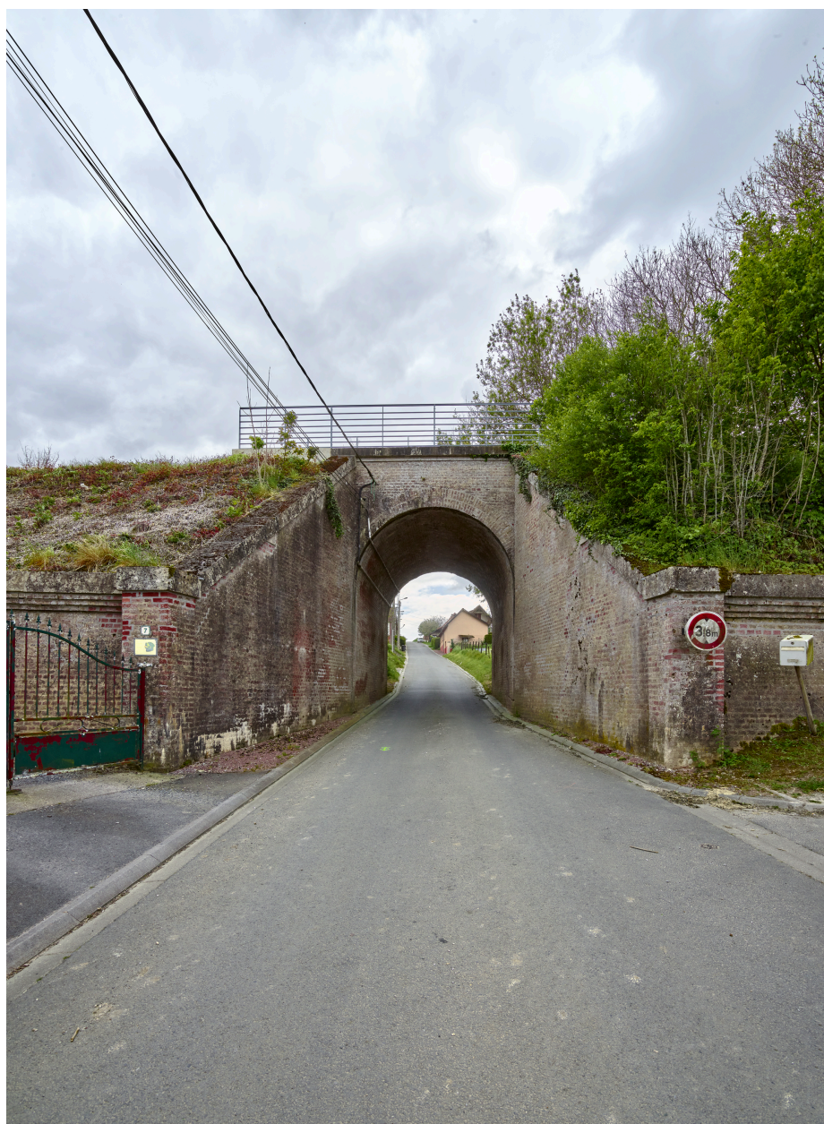
Ancien pont ferroviaire de la rue du Haut, depuis le nord.
