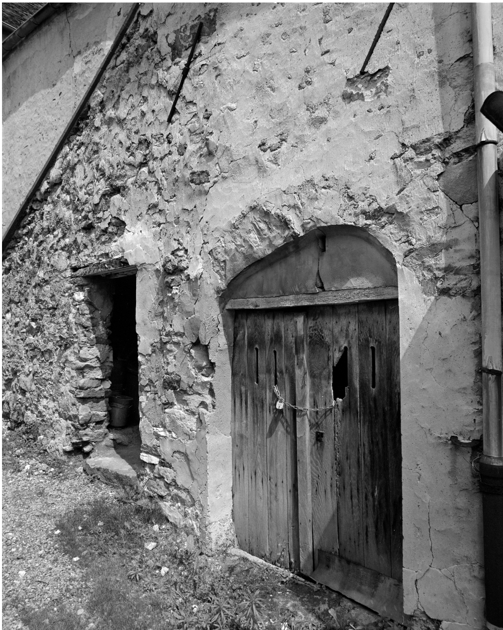
Détail d'une porte de cave sous l'escalier extérieur.
