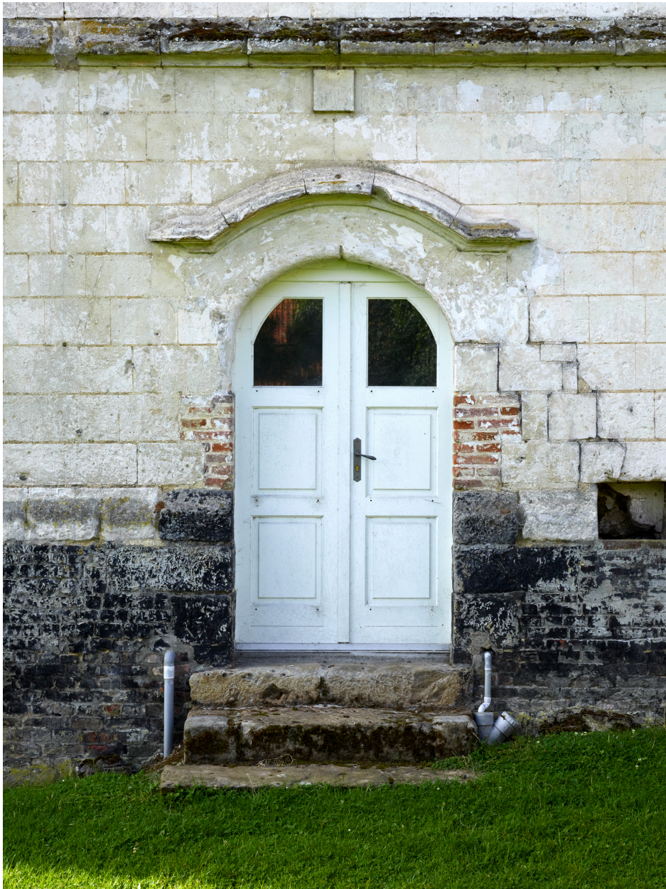
Détail de la porte de la façade nord du manoir.
