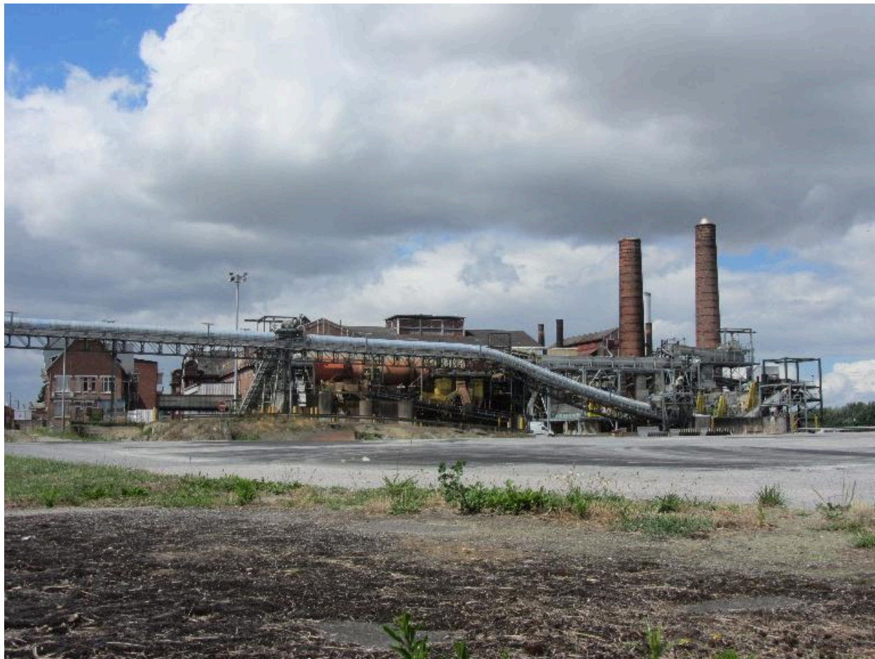
Vue d'ensemble est de l'usine, depuis l'aire de réception des betteraves.
