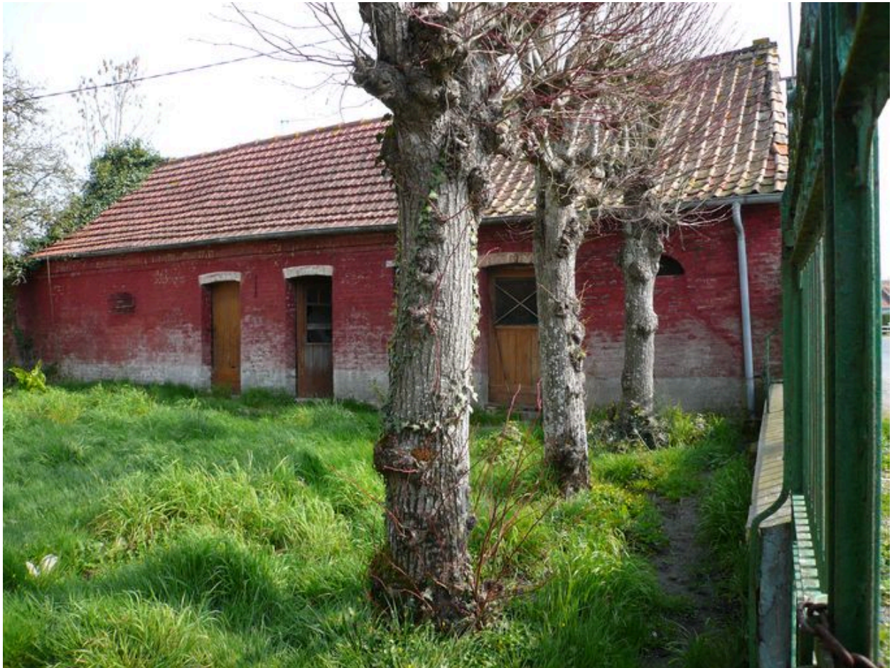
Vue des étables à l'est de la cour.
