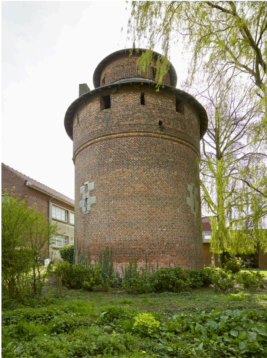
Vue générale de la tour prise depuis le nord.
