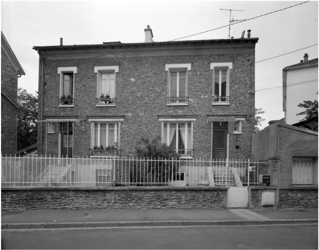
Vue d'ensemble de la maison avec le numéro 14.
