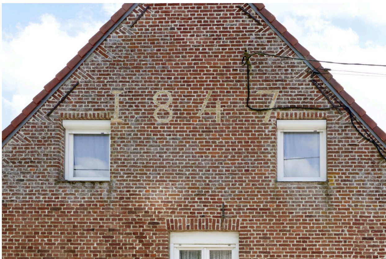
Pignon ouest du logis avec date portée "1847" en brique jaune.
