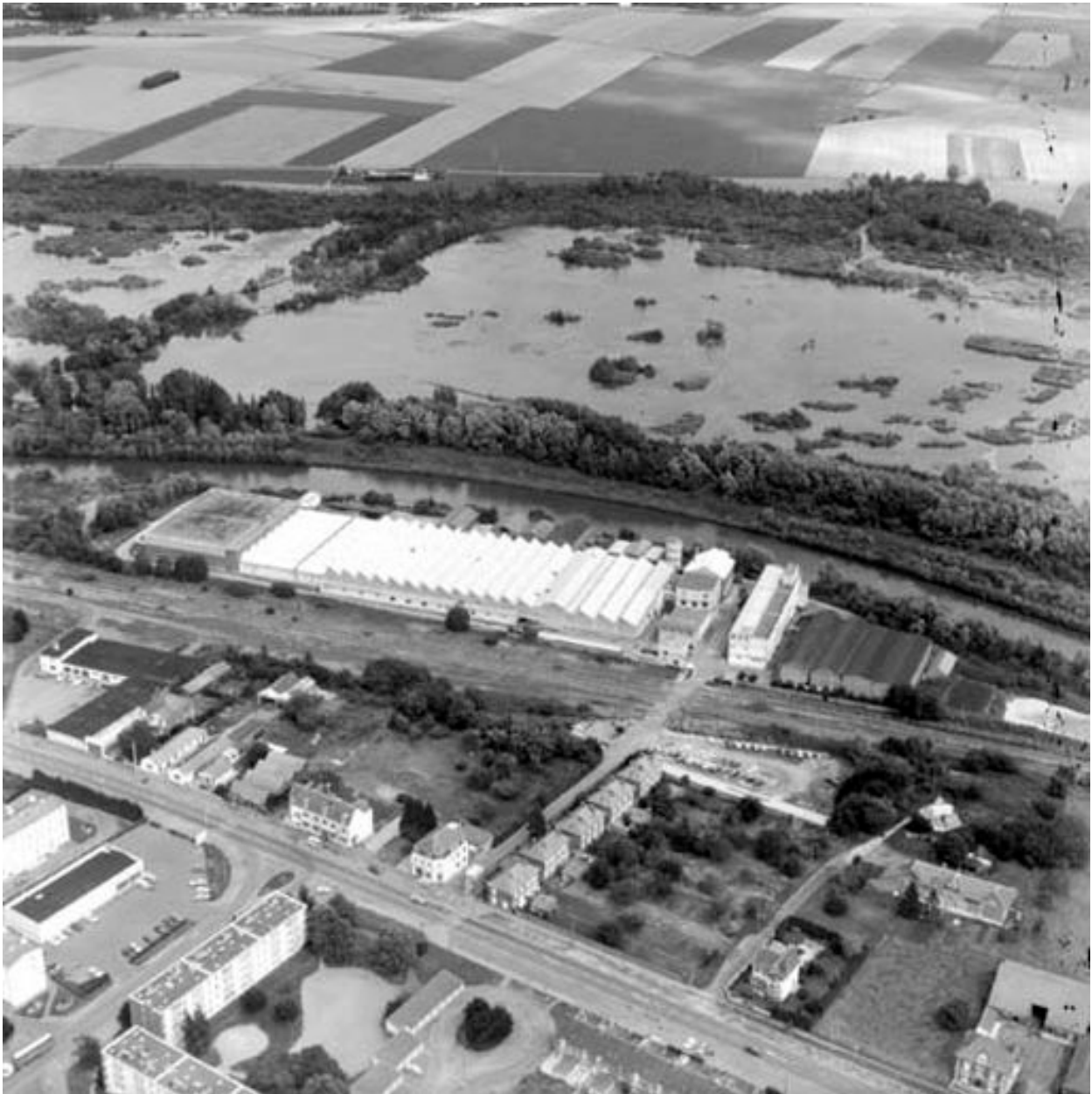
Vue aérienne, flanc sud.
