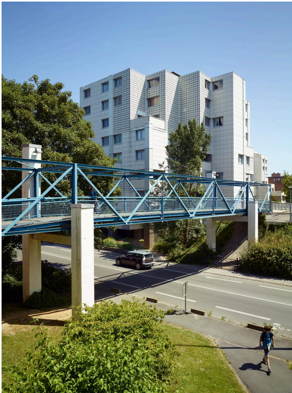
Passerelle piétonne sur le boulevard Van-Gogh (quartier de l'Hôtel-de-Ville).
