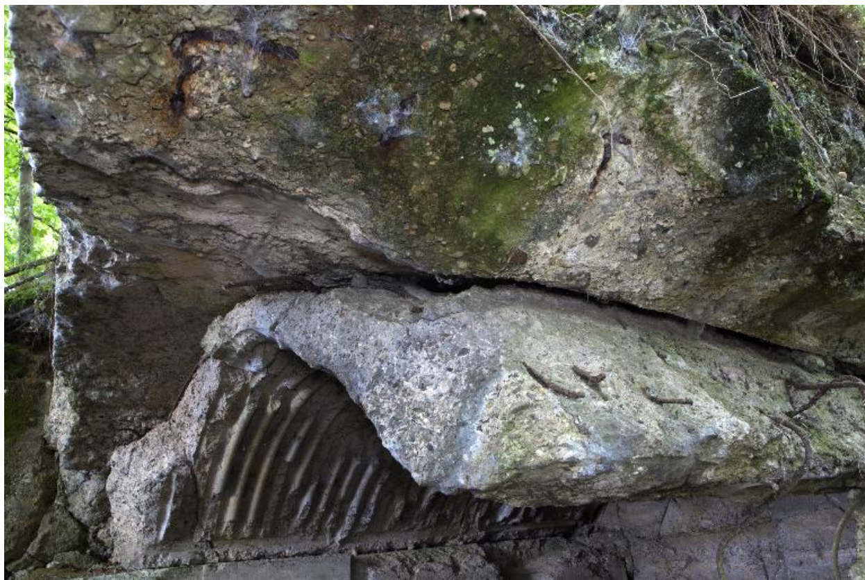
Casemate n°1, détail de la voûte
