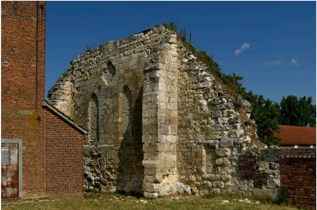
Vue générale du pignon sud de l'ancienne grange cistercienne.
