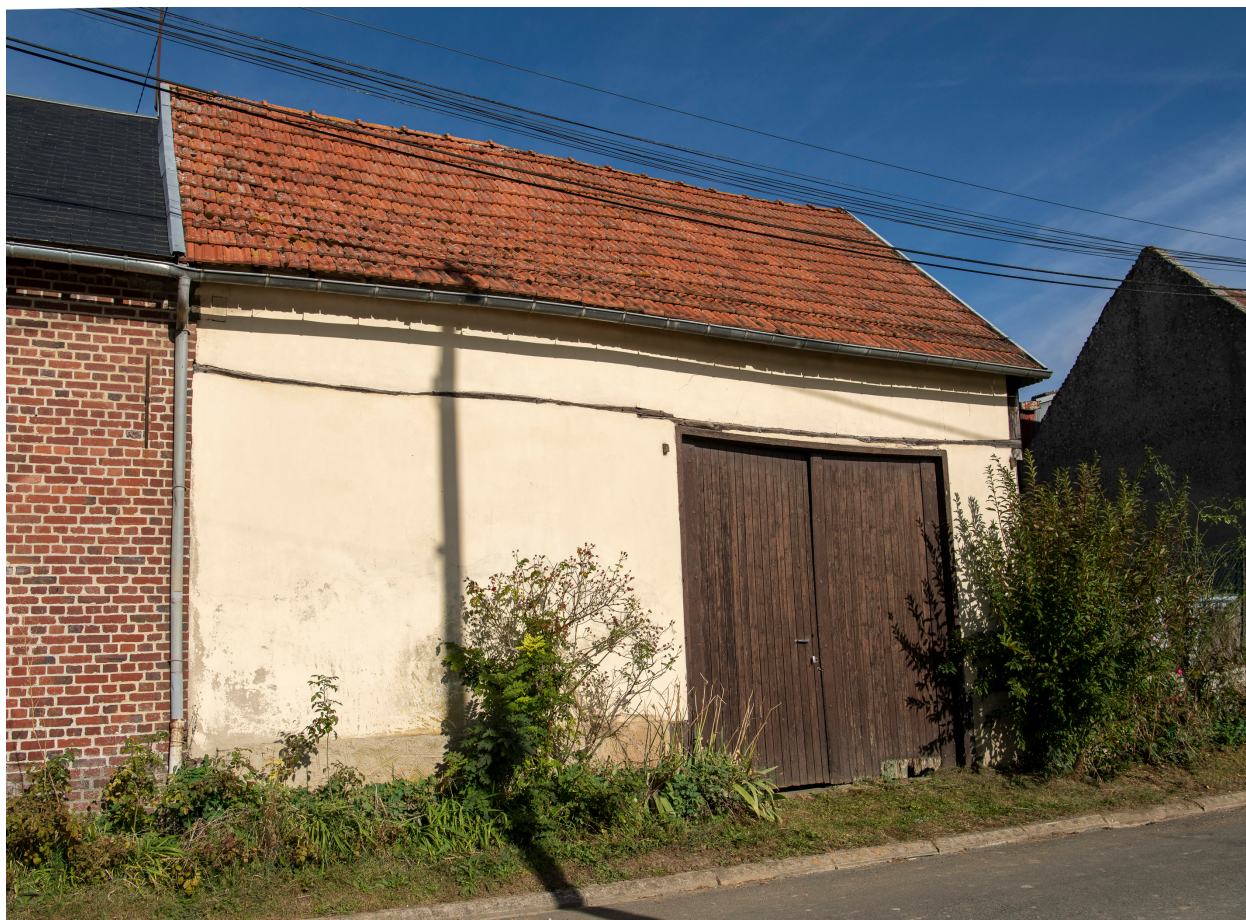
Grange en torchis sur la rue, n°3 rue du Cardonnois, vue prise depuis l'ouest.
