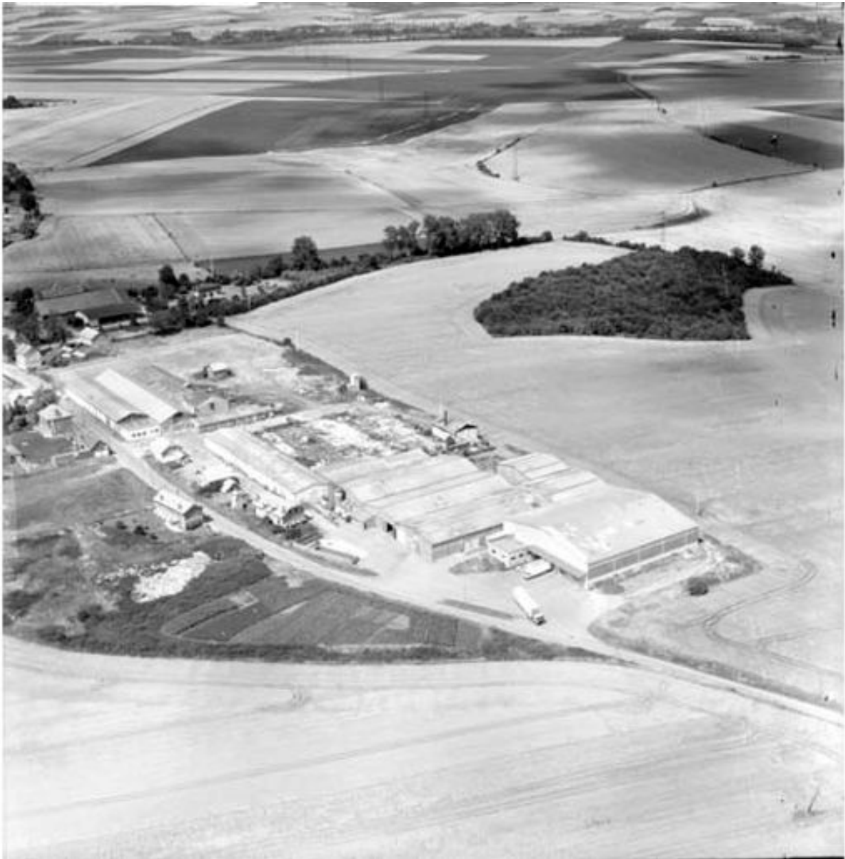
Vue aérienne de l'usine, flanc sud ouest.
