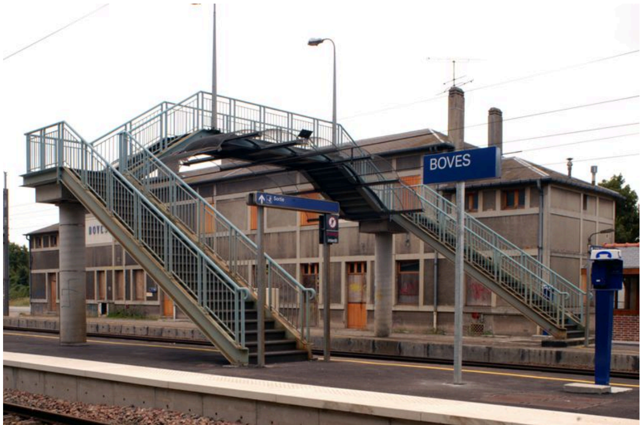
Vue de la façade est, depuis le nord.
