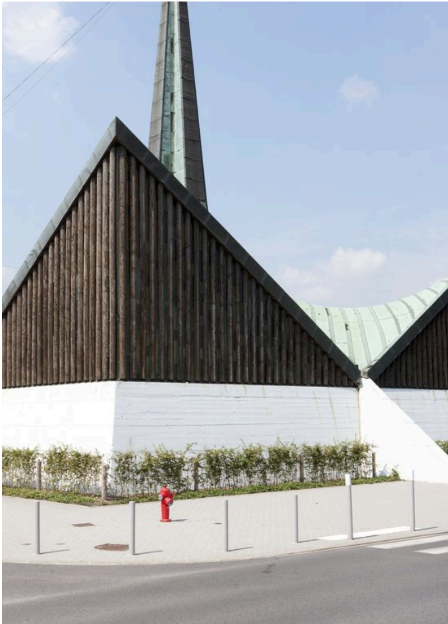
Vue de l'angle, entre les élévations sud et est.
