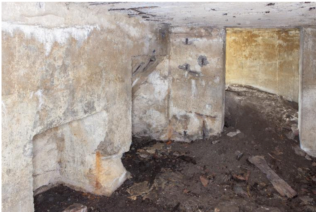
Casemate B : Vue intérieure, vers le nord
