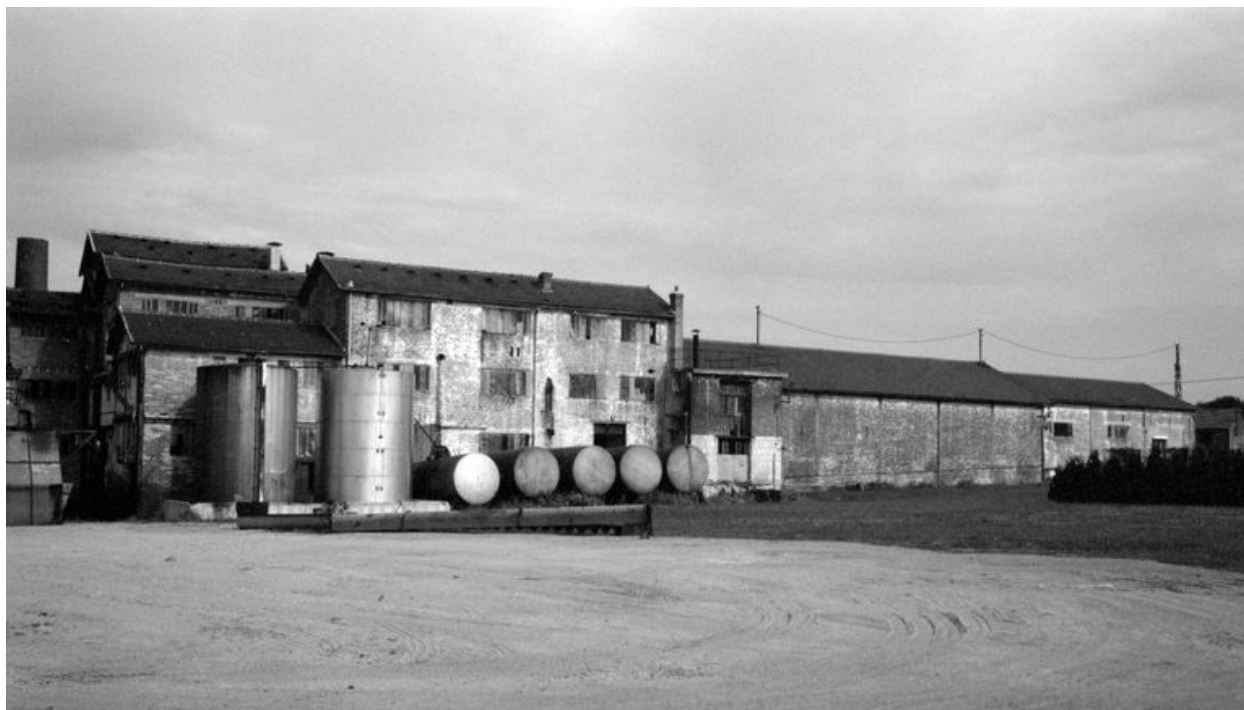
Vue générale : flanc ouest.
