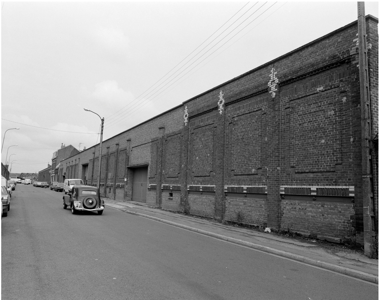
La filature, rue Pierre-Brossolette, vers le nord-est.
