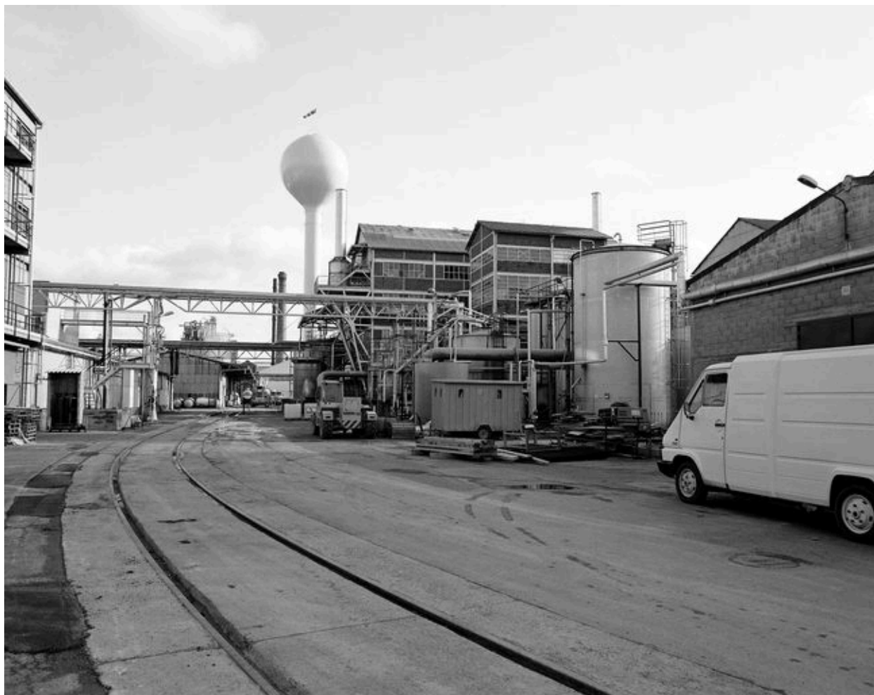
Atelier de fabrication et château d'eau.
