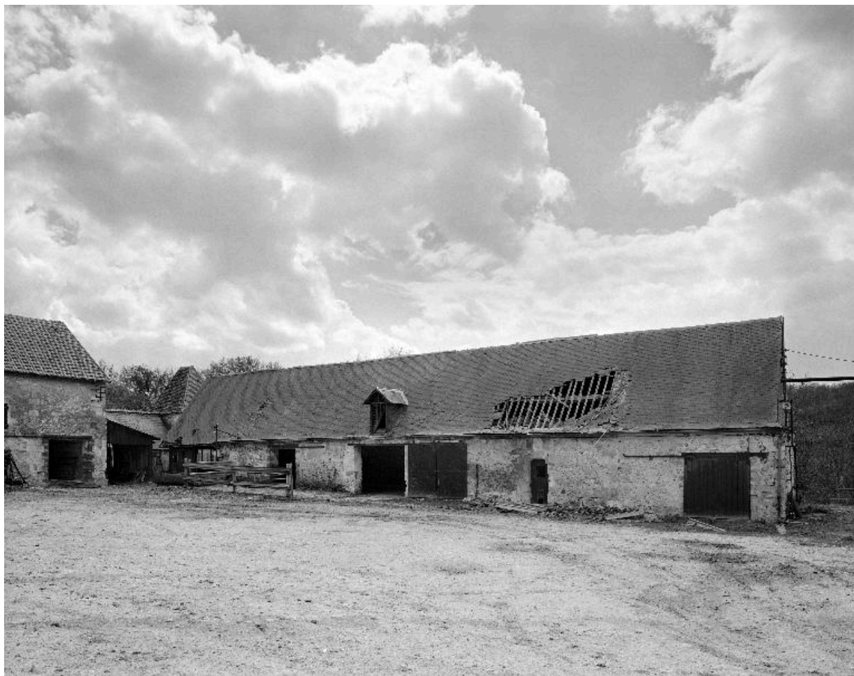
Bâtiment sud-ouest : élévation sur cour.
