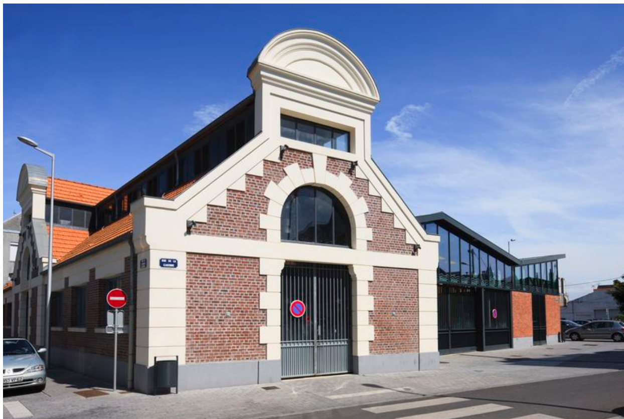
Vue générale de l'entrée ouest.
