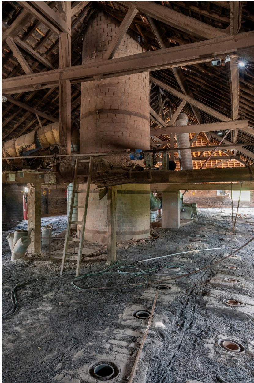
Couvrement du four Hoffmann. Cheminée d'évacuation des fumées.
