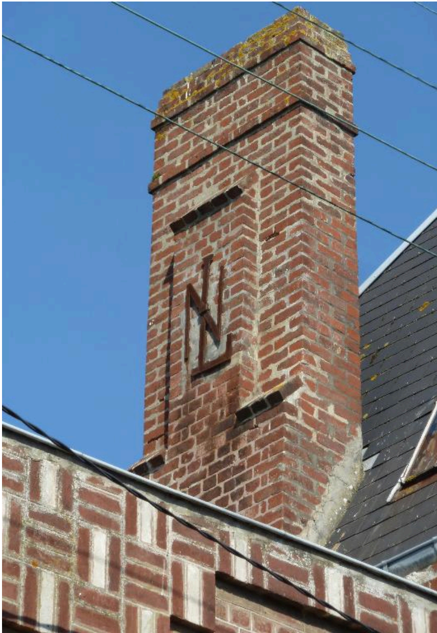
La marque du fabricant LN, en fer d'ancrage sur la souche de cheminée.
