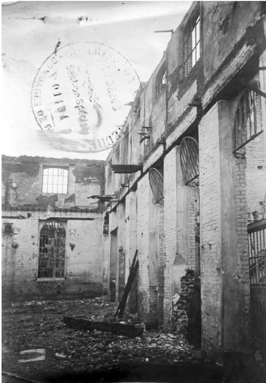
Photographie des ateliers en ruine prise avant les travaux de reconstruction (AD Aisne).
