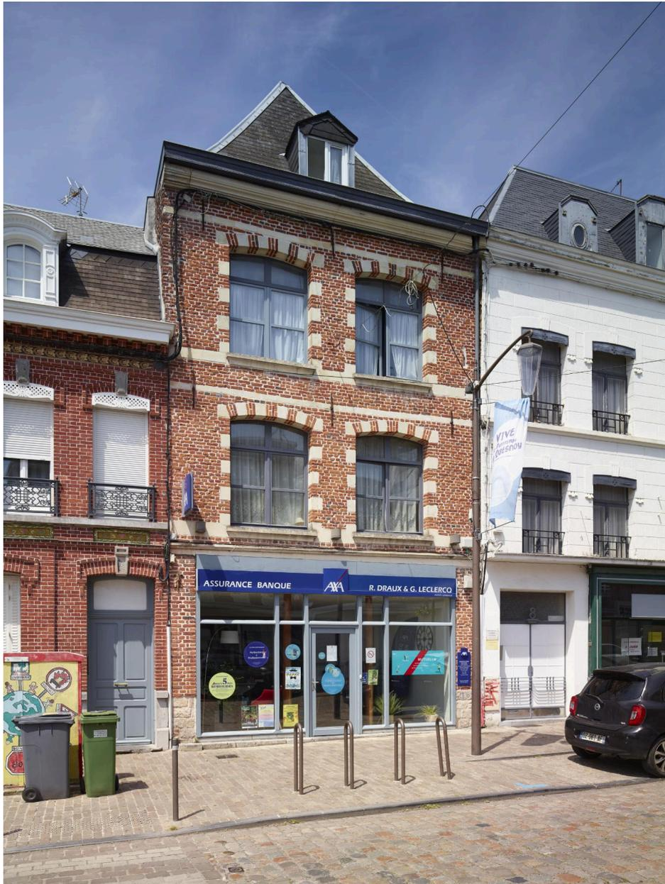
Vue de face : la toiture à longs pans et croupe ainsi que l'alternance de brique et de moellons de calcaire dans l'entourage des baies sont typiques de la 1ère moitié du XVIIIème siècle.
