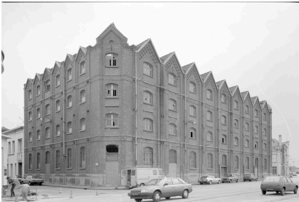
Vue générale, façades sur rue du Gros Jack et quai Freycinet.
