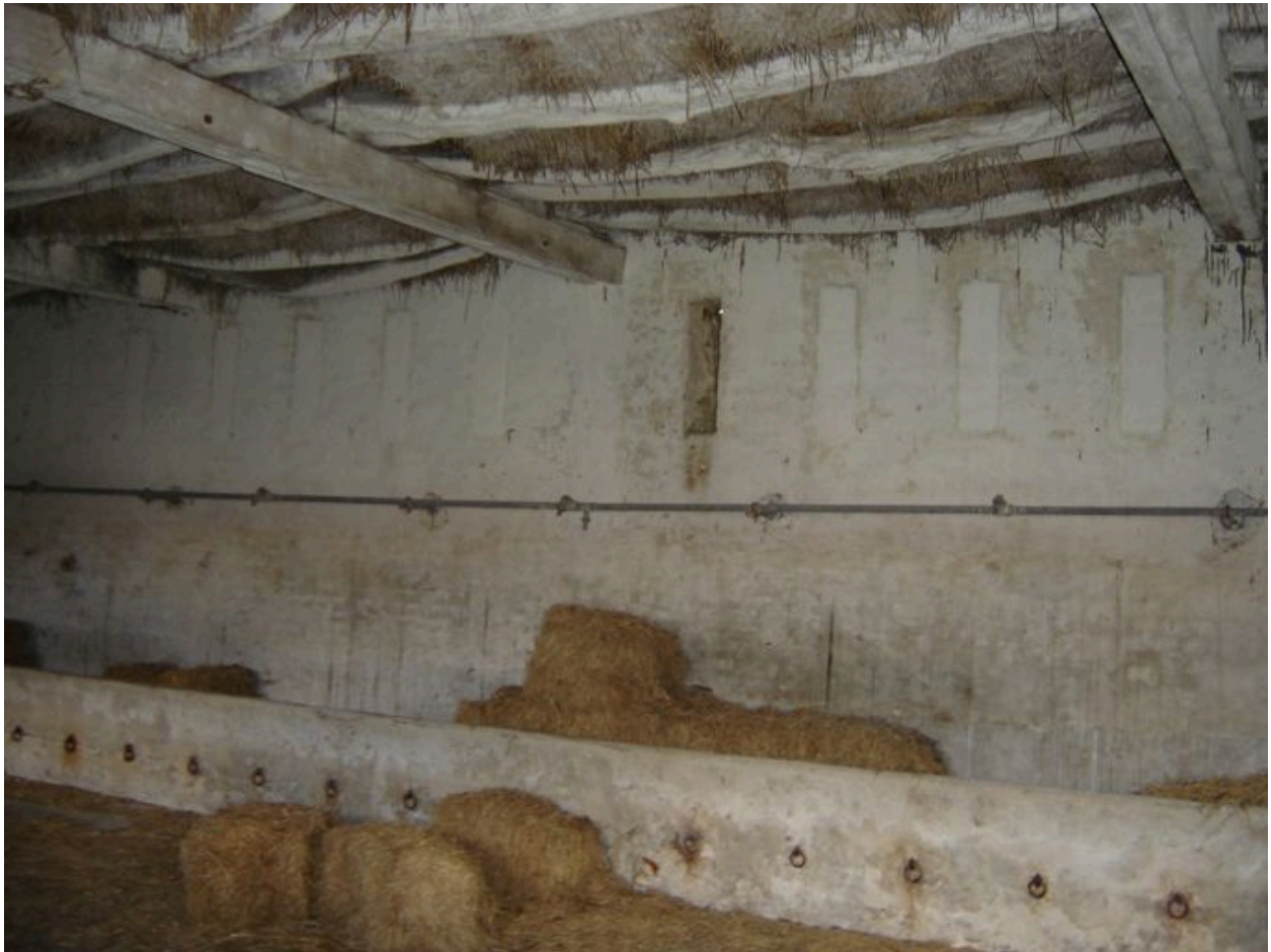
Vue intérieure des étables (bâtiment sud).
