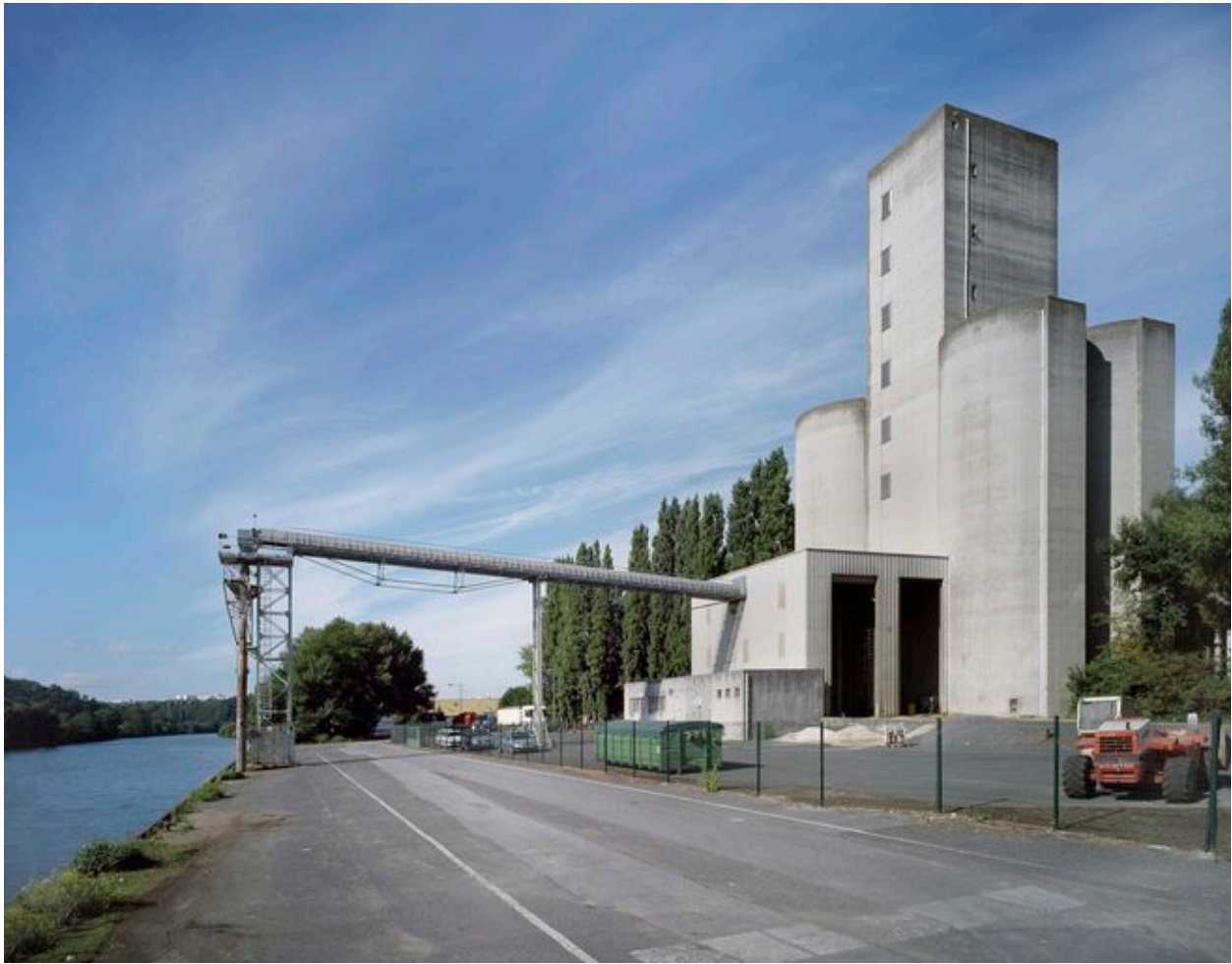
Vue générale du silo de Nogent-sur-Oise
