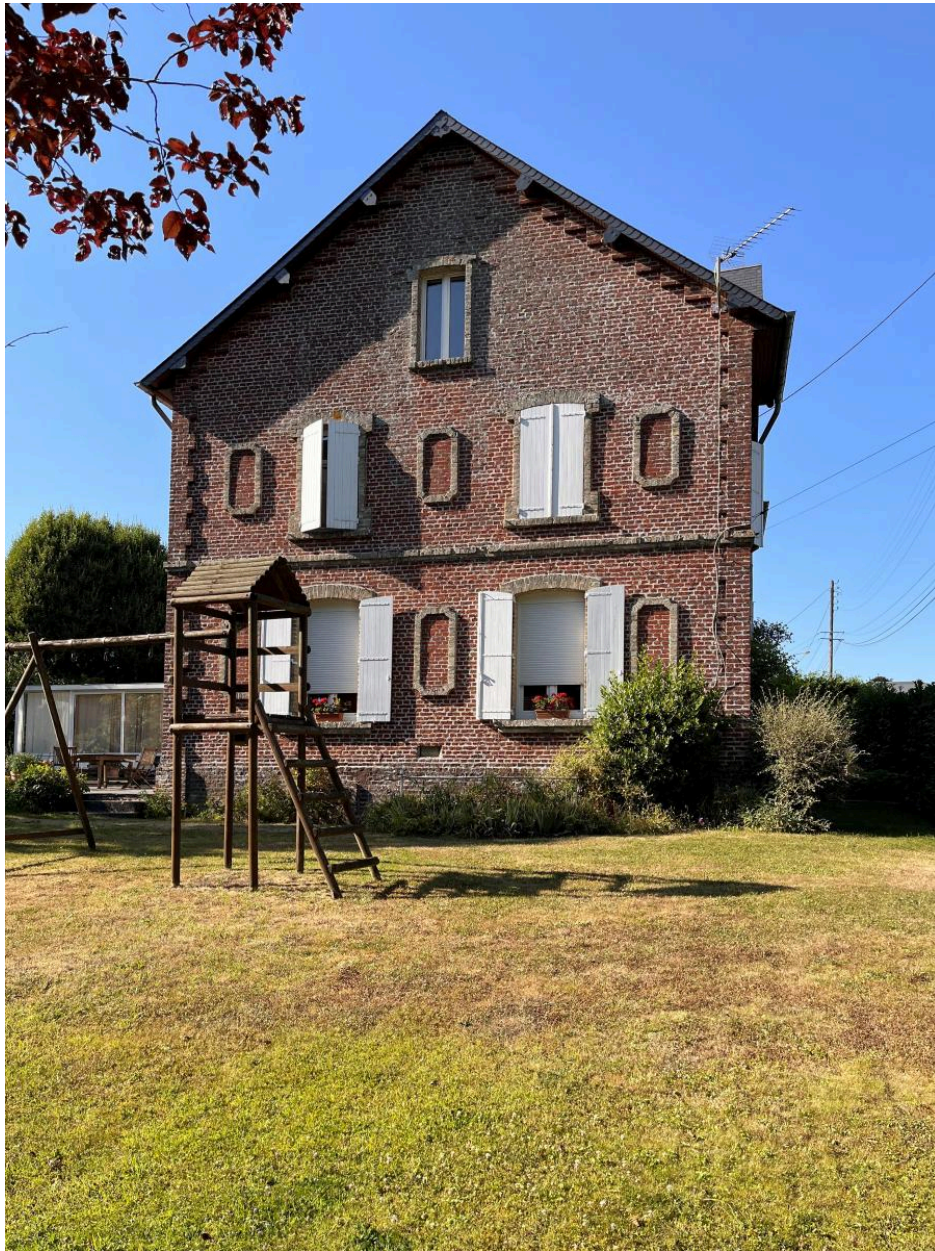
Logement de contremaître, vue du pignon depuis le jardin.
