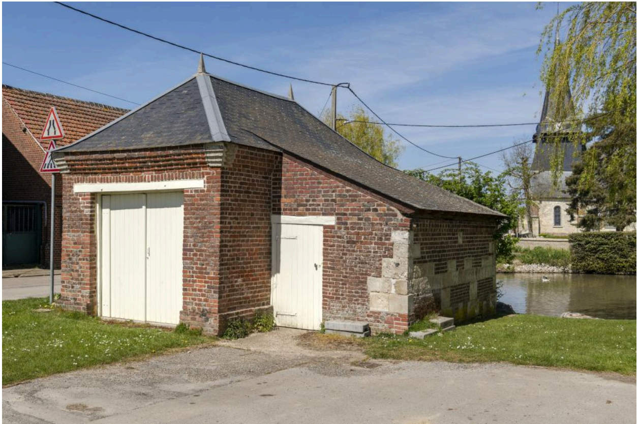
Bâtiment des pompes et abri pour les indigents, vue depuis le sud.
