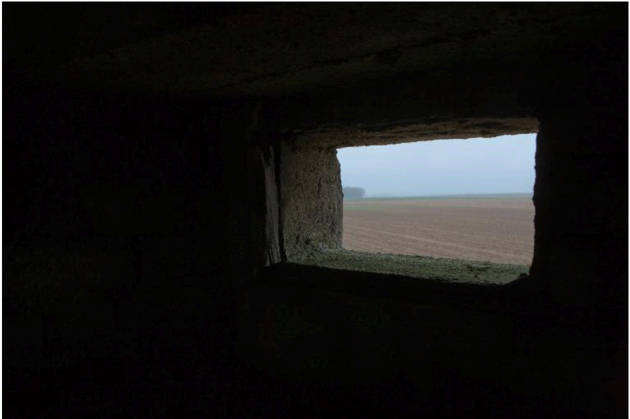
Vue de détail d'une ouverture.
