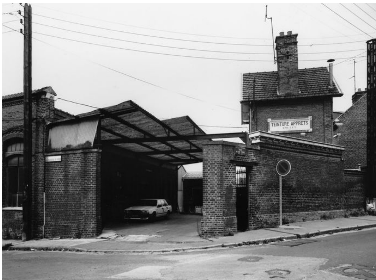
La conciergerie et l'entrée de l'usine.
