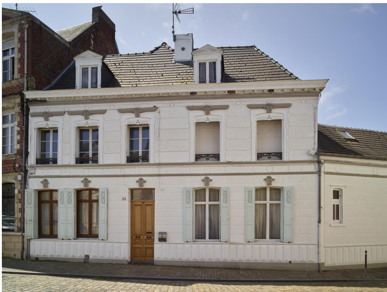
Maison, 26 place du Général-Leclerc : enduit nid d'abeille utilisé pour les tables horizontales superposées dans les trumeaux.
