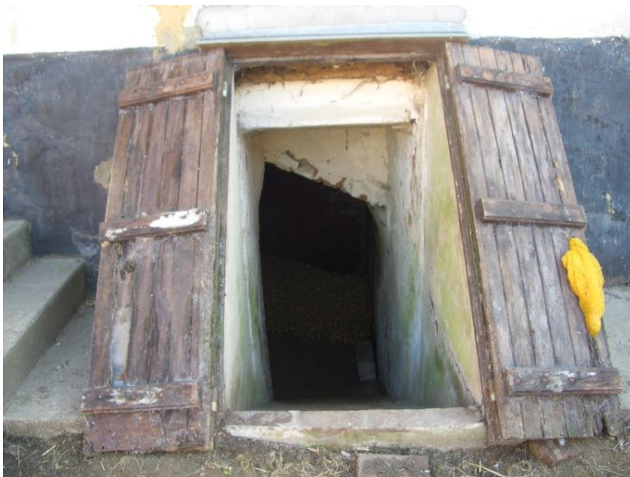
Entrée de la cave en façade.
