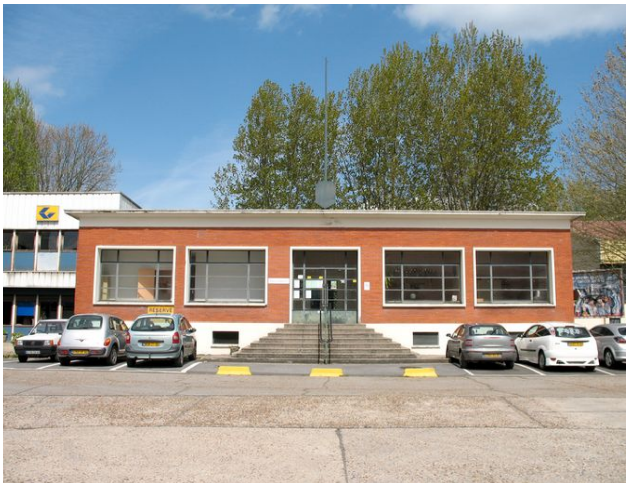
Bâtiment des douches construit en 1957 face à l'entrée de l'usine.
