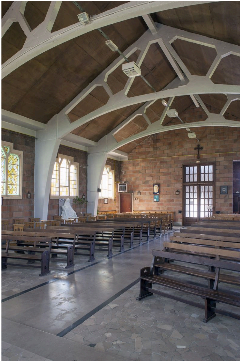
Vue générale depuis le chœur.
